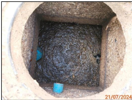
บ่อกักน้ำก่อนผ่านระบบบำบัดน้ำเสียอาคารที่พักผู้โดยสาร ชุดที่ 2
