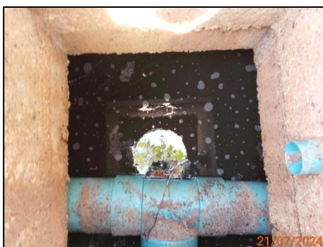
บ่อกักน้ำหลังผ่านระบบบำบัดน้ำเสียอาคารที่พักผู้โดยสาร ชุดที่ 2
