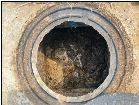
บ่อบำบัดน้ำก่อนผ่านระบบบำบัดน้ำเสียอาคารที่พักผู้โดยสาร ชุดที่ 3
